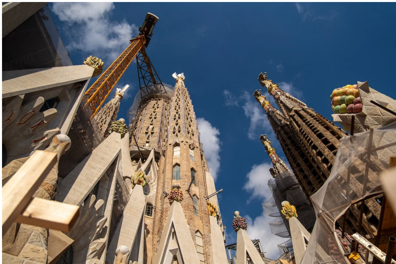
La torre in costruzione nella basilica della Sagrada Família a Barcellona (©Eric Renom/LaPresse)
